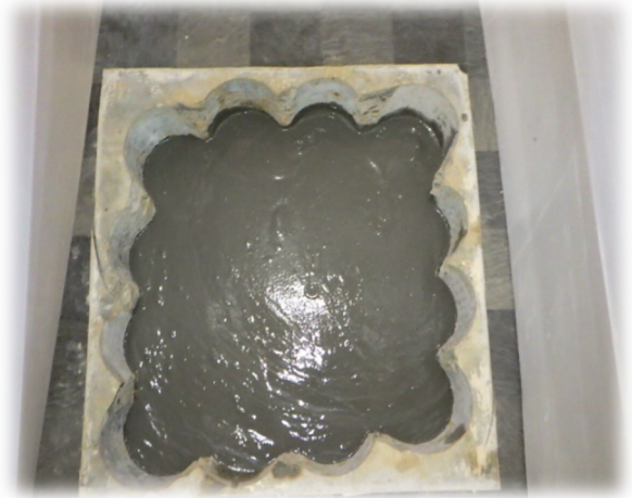
流動化処理土打設後
