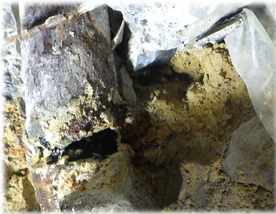
埋設既設雑排水管
