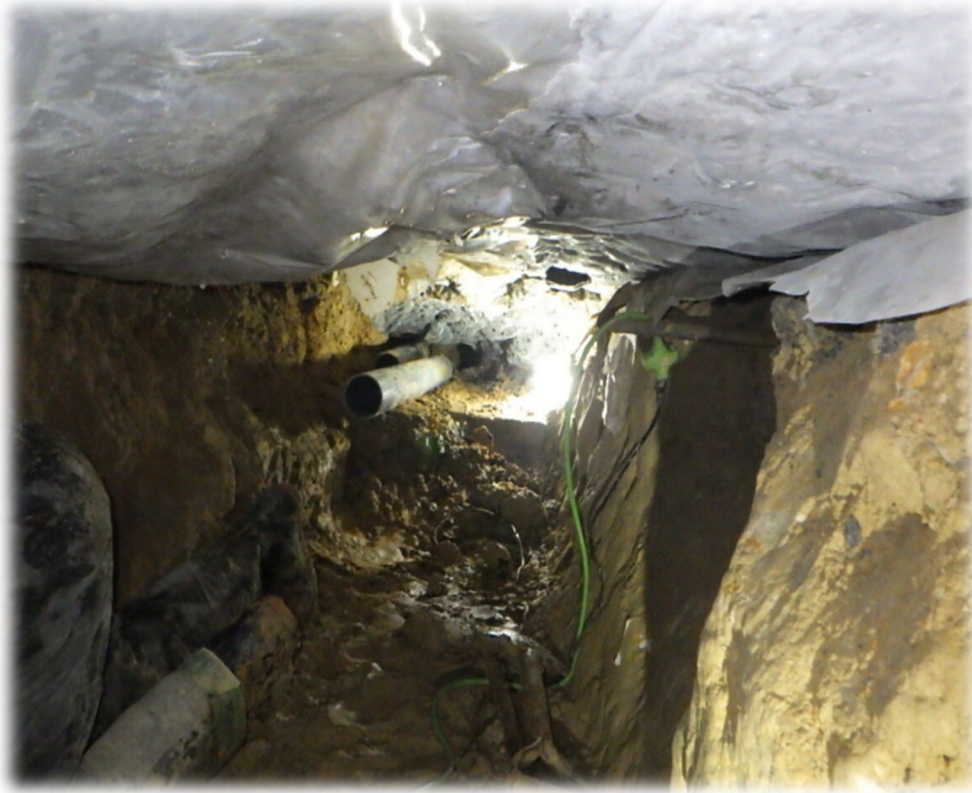
既設埋設排水管撤去
