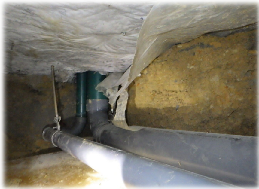
床下埋設排水管更新
