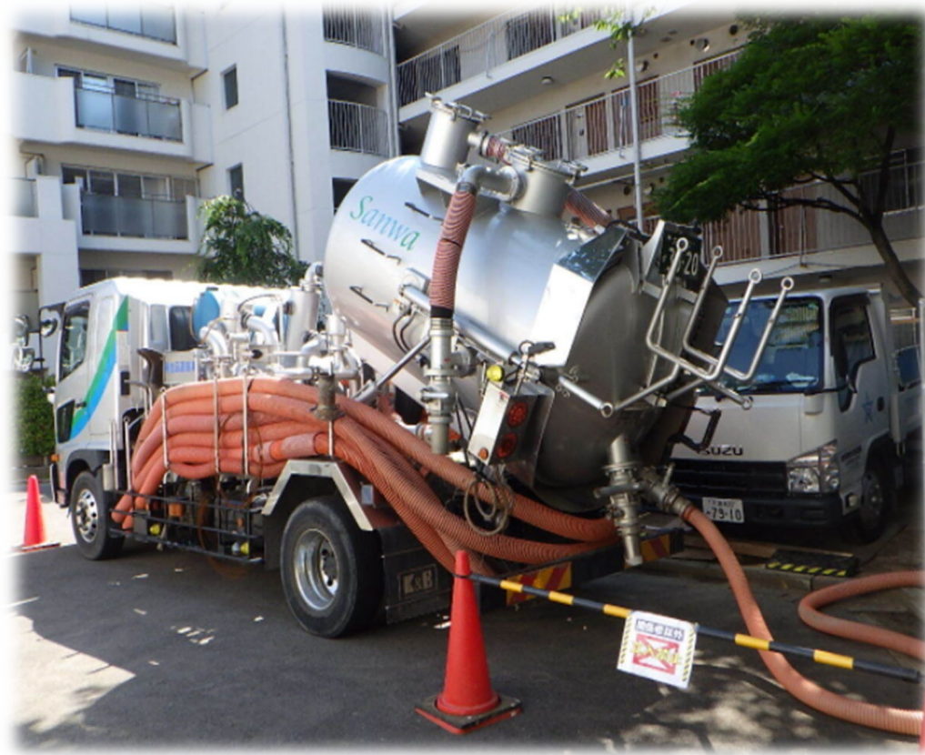
流動化処理土ポンプ車
