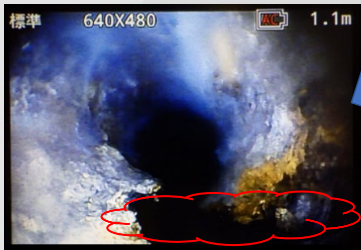
1 階床下埋設排水管の状況
