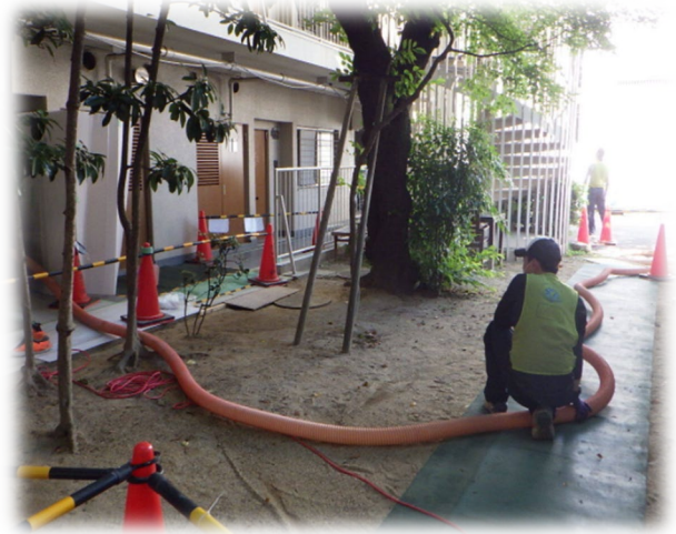
流動化処理土打設
