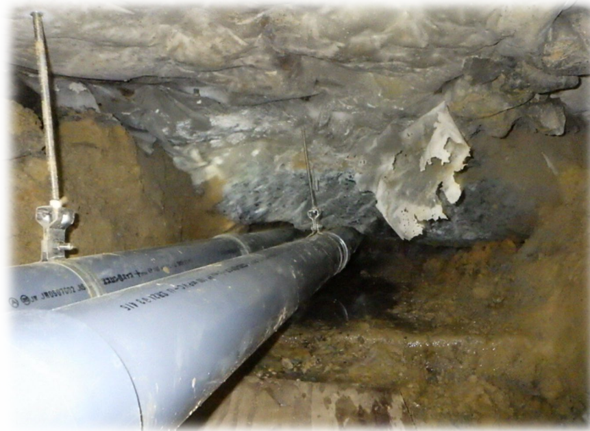
床下埋設排水管更新
