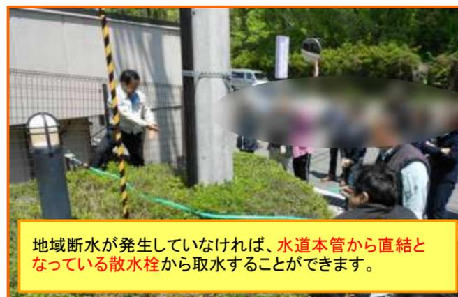
地域断水が発生していなければ、水道本管から直結となっている散水栓から取水することができます。
