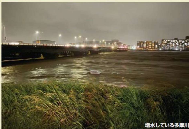
増水している多摩川
