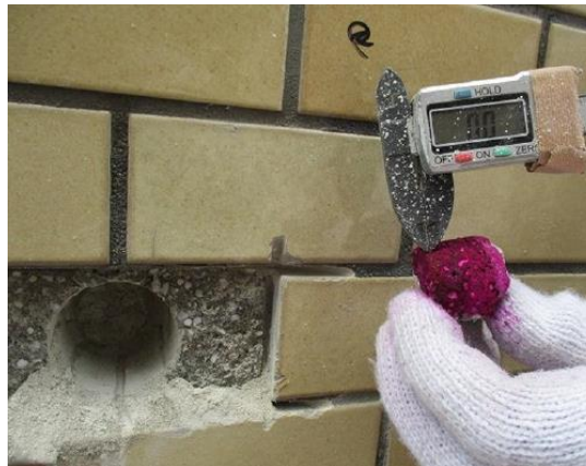
コンクリート中性化測定
