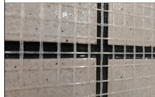
四ツ谷駅構内施工事例
