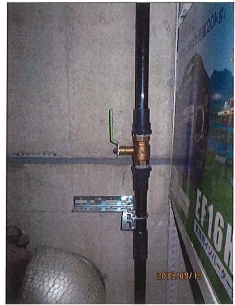
②ホームポンプ後の給水配管のバルブを開ける
