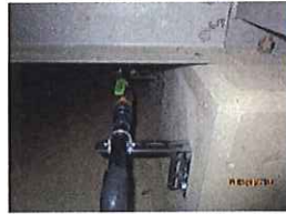
受水槽下部の取出し配管のバルブ
