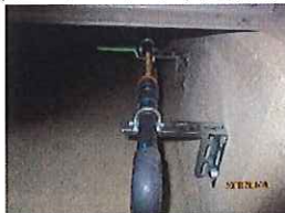
受水槽下部の取出し配管のバルブ
