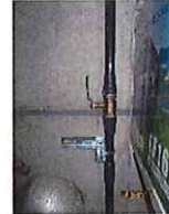
ホームポンプ後の給水配管のバルブ
