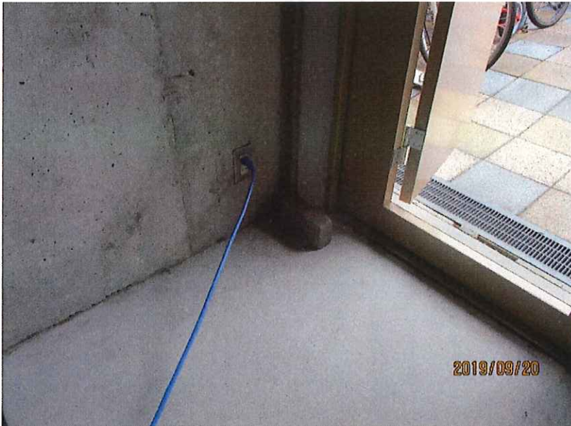
③電工ドラムのプラグをコンセントに挿入する ※停電の場合は屋外で発電機を運転し発電機に接続する
