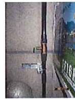
ホームポンプ後の給水配管のバルブ
