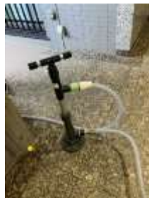
手動ポンプに接続します。
