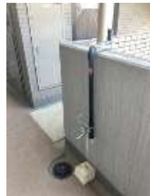
9階(上の階)から設置します。
