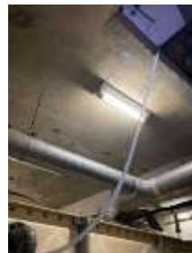
地下受水槽からホースをつなぎます。
