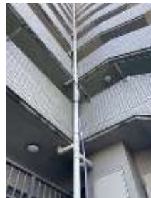
上階からホースを垂らし接続します。
