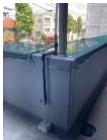
2階はネットの隙間に設置します。
